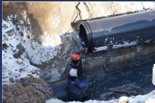
Диаметр коллектора – 1400 мм. Протяженность участка 50 метров.
