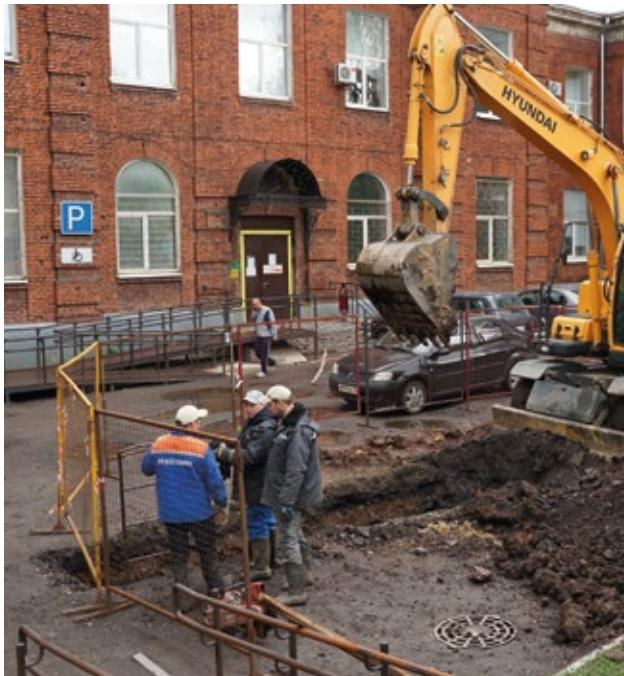
Переврезка – это процесс переключения абонентов от старого водопровода к новому. Улица Носкова входит в национальный проект БКАД, поэтому было принято решение оперативно обновить сети перед ремонтом асфальтового покрытия. На месте одновременно работали шесть бригад. Раскопки производились минимально, так как работы выполнялись методом ГНБ (горизонтальное направленное бурение).
