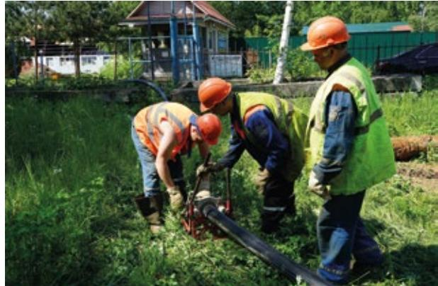
Протяженность участка 220 метров. Здесь происходит закольцовка водопровода: улица Столярная соединяется с улицей Дачной. Закольцовка необходима для улучшения качества воды, чтобы не было тупиковых сетей. Отключений водоснабжения в домах удалось избежать путем переключения на резервные источники.
