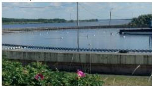
Осветленная вода с первичных отстойников поступает в аэротенки, где происходит биологическая очистка сточных вод с помощью активного ила и кислорода воздуха. Аэротенки представляют собой железобетонные резервуары, через которые медленно протекают подвергающиеся аэрации сточные воды, смешанные с активным илом.
