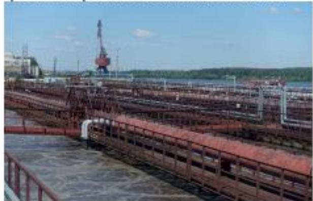
Далее смесь очищаемой воды и активного ила поступает во вторичные отстойники, которые предназначены для отделения активного ила от биологически очищенной воды.
